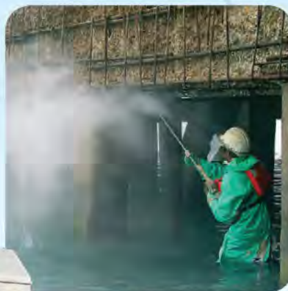
Видалення бетону 1000 bar
